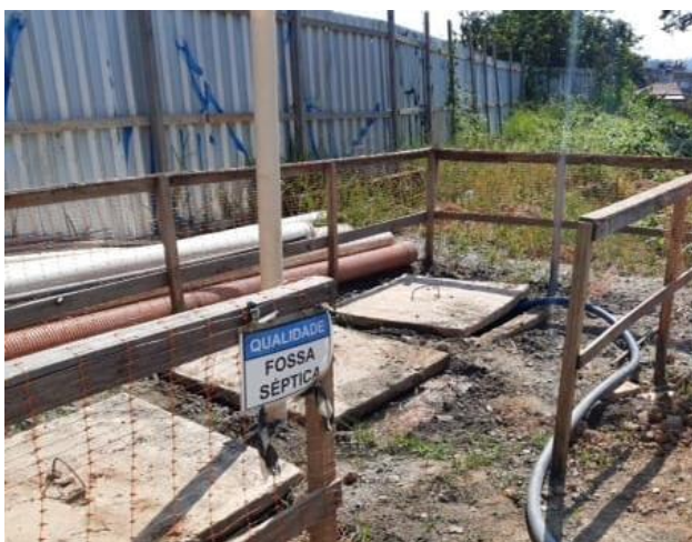
FOTO 7 – LIMPEZA DA FOSSA SÉPTICA
