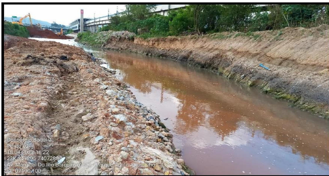
Foto 2 – Taludes sob intervenção e vegetação suprimida – Ponto 02.
