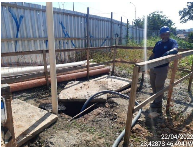
FOTO 4 – LIMPEZA DA FOSSA SÉPTICA
