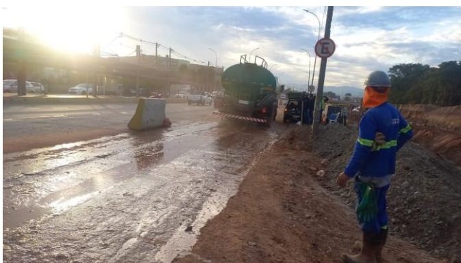
FOTO 8 – LIMPEZA DE VIA PÚBLICA
